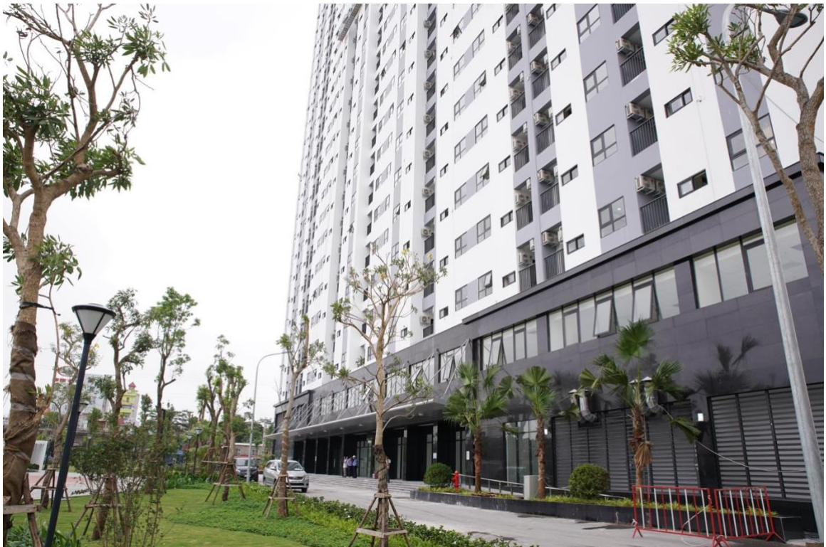
Một góc cụm chung cư HH3, HH4 được TCH đầu tư
