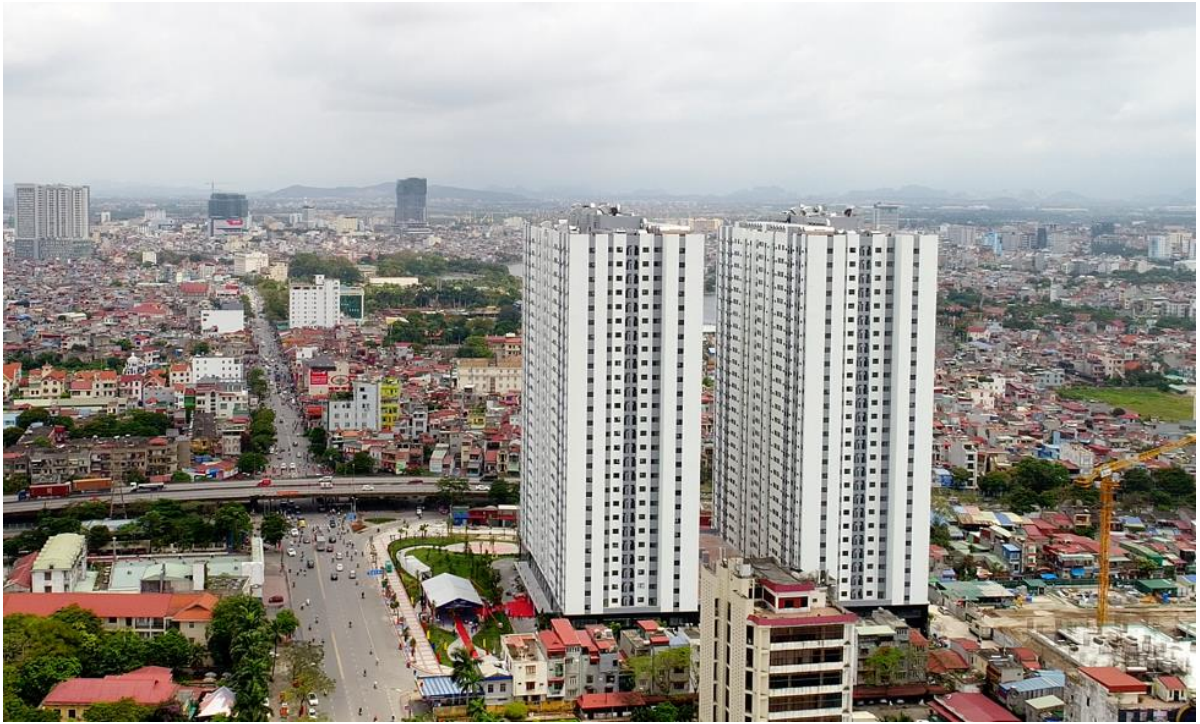
Hai toà chung cư HH3, HH4 mới được TCH hoàn thành
